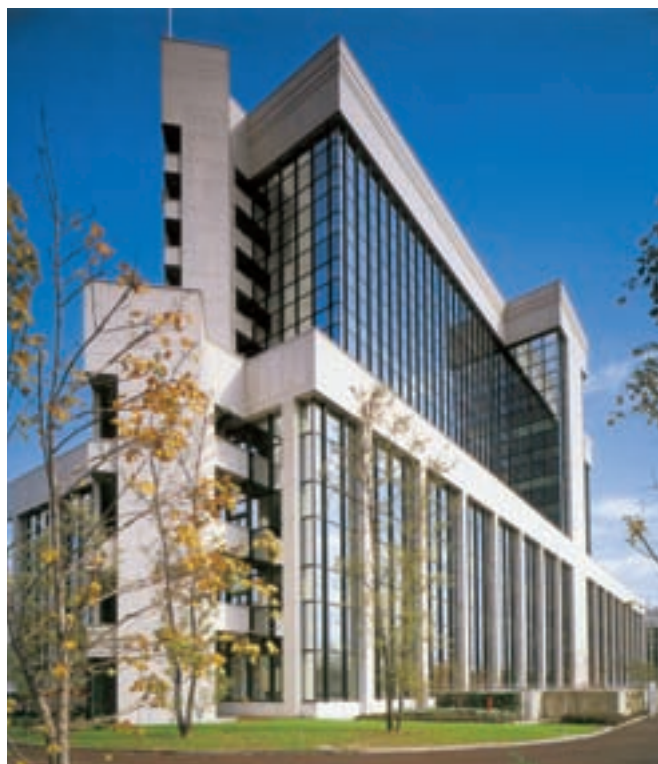
Lo stabile di UniCredit, in Via Sant’Elia a Milano richiama volutamente lo stile dell’architetto comasco.
